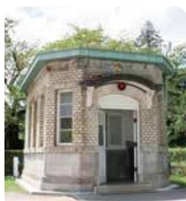
写真4 向かって左半分は銅板に塗装が施されている様子。右半分は塗装を落とし、銅板が現れている
